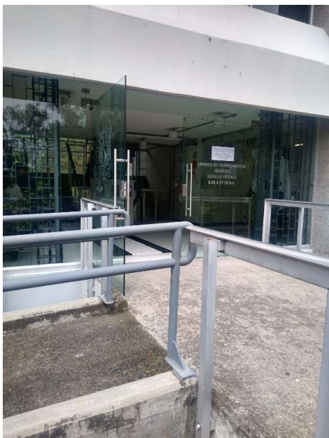
Acceso amplio para permitir maniobras a sillas de ruedas.
