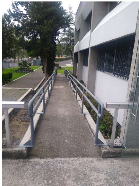
El acceso a la UT cuenta con rampa de acceso para personas con discapacidad.
